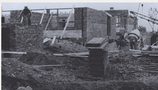
Budowa nowej szkoły 1960 r.
